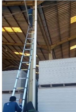
Gambar 4.1. Proses penarikan kabel
