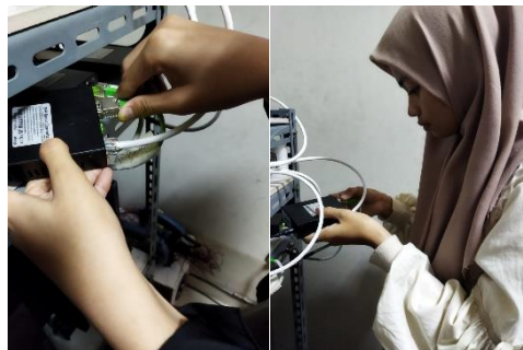
Gambar 4.5. Proses pemasangan converter
